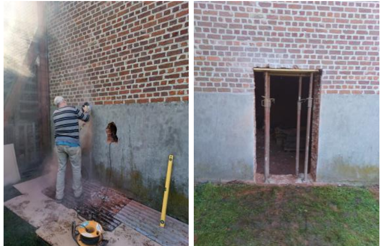
Een voorlopige opening uitgeslepen en gekapt waar de deur komt.
